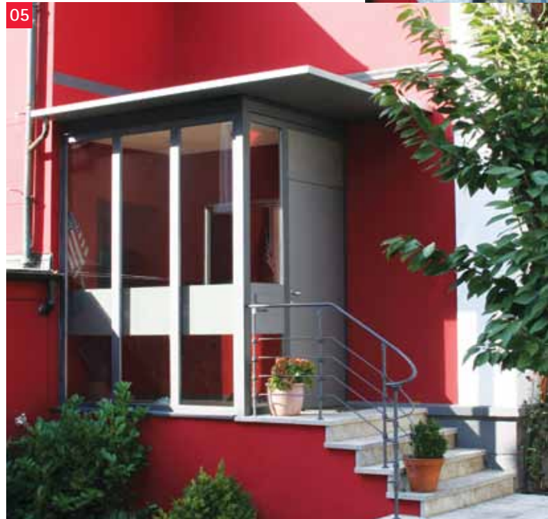
05 Eingangshaus mit Geländer, Stahl geschmiedet, feuerverzinkt und beschichtet. Konstruktion System Janisol, Fa. Jansen- Schweiz Haustür und Regale innen mit Eichenholz belegt. Privathaus Essen: in Zusammenarbeit mit dem Architekturbüro Knirr und Pittig Essen
