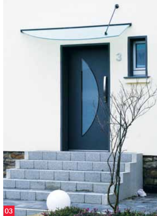
03 Vordach, Stahl feuerverzinkt und beschichtet, VSG aus TVG mit Satinatofolie
